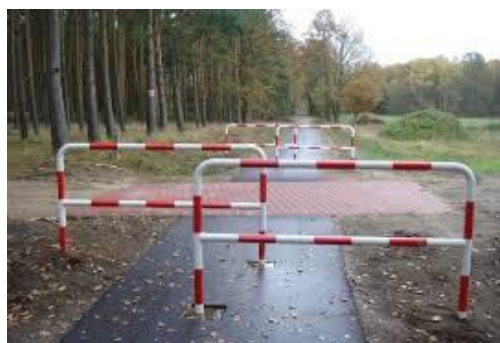
Rysunek nr 65. Barierki ograniczające bezpośredni wjazd na jezdnię Źródło: Materiały własne
