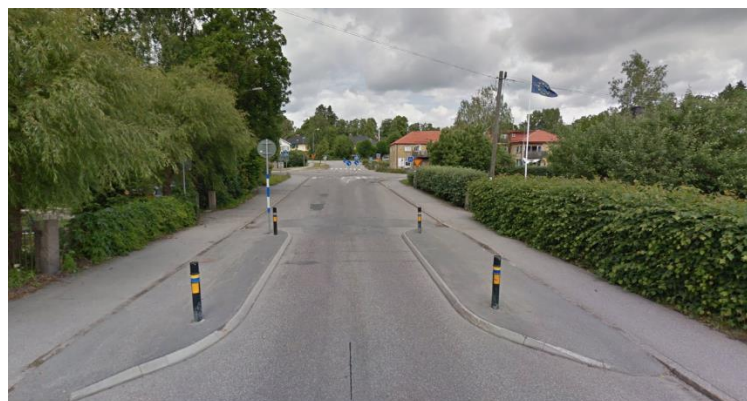
Rysunek nr 32. Przykład zwężenia jezdni
