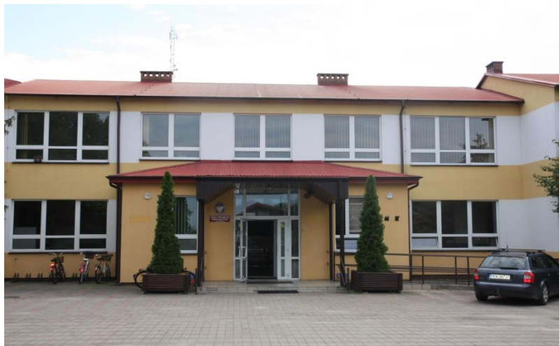
Rys. 1. Budynek Szkoły Podstawowej im. Bolesława Prusa w Liścu Wielkim
