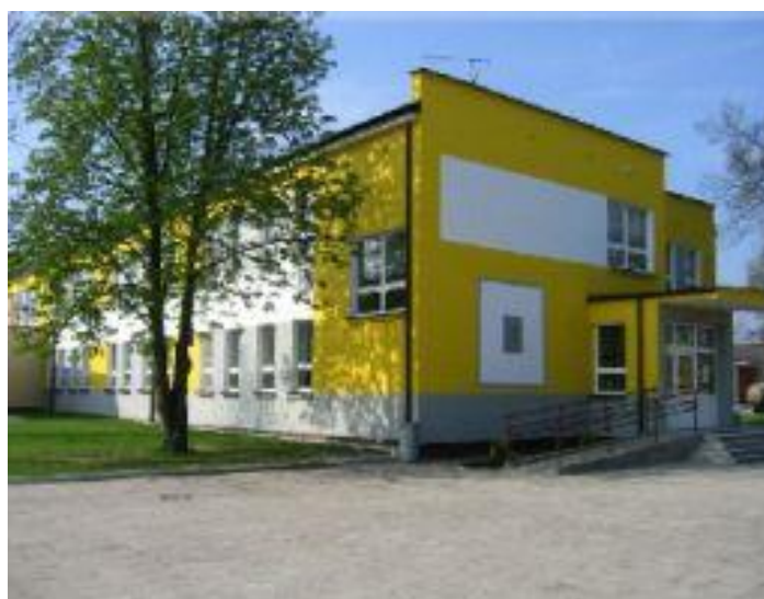
Rys. 1. Budynek Szkoły Podstawowej w Starym Mieście.
