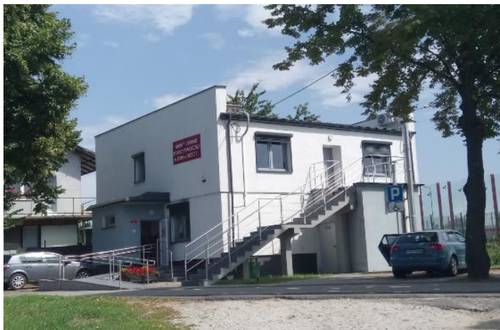
Rys. 1. Budynek Gminnego Ośrodka Pomocy Społecznej w Starym Mieście
