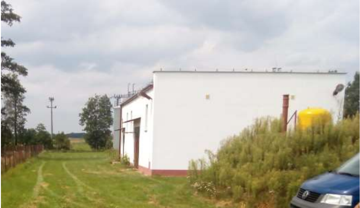
Rys. 1. Hydrofornia w Liścu Wielkim
